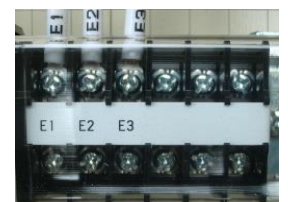
TB2: 水位計(電極等)端子詳細
