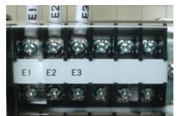
TB2: 水位計(電極等)端子詳細
